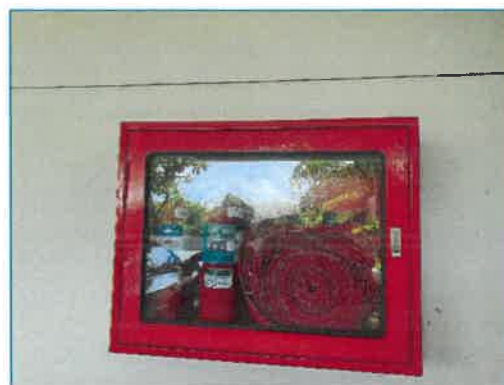
ถังดับเพลิงและสายฉีดน้ำดับเพลิง
